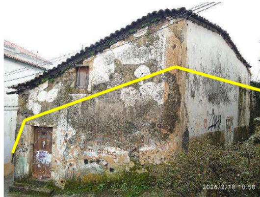
Foto 13. Proposta de demolição edificação na Rua do Cotovelo (continuação).
