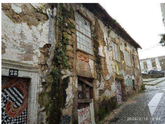
Foto 1. Fachada principal do edifício localizado na Rua Alexandre Herculano n.º 24 e 26
