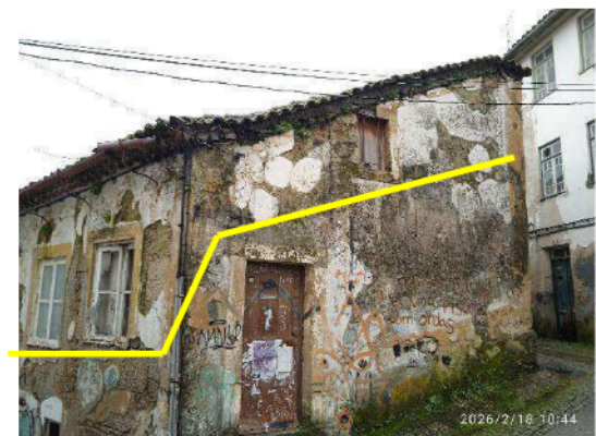
Foto 12. Proposta de demolição edificação na Rua do Cotovelo n.º 34.
