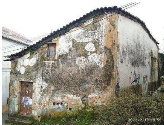
Foto 6. Fachada do imóvel, Rua do Cotovelo
