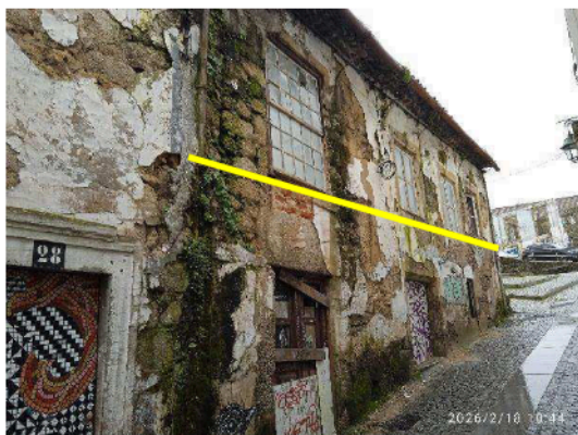
Foto 11. Proposta de demolição edificação na Rua Alexandre Herculano n.º 24 e 26
